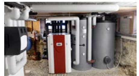
Wärmepumpen wandeln die Umweltwärme tieferer Temperatur in Heizwärme höherer Temperatur um. Das Bild zeigt eine Wärmepumpe, die Erdwärme mithilfe einer Erdsonde nutzt.
