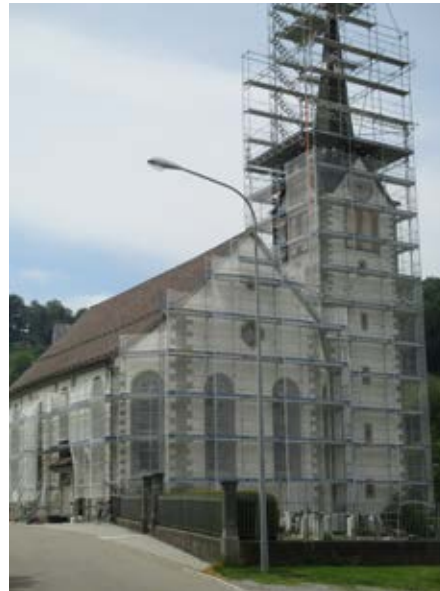
Die 266 Jahre alte Grubenmannkirche von Grub AR wird derzeit sorgfältig restauriert.
