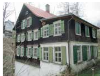
Das «Zwirneli» in Lachen ob Walzenhausen ist ein einzigartiges Industriedenkmal
