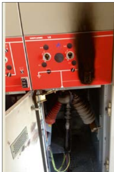
Zerstörter Mittelspannungsschalter der Trafostation Schwarzenegg
